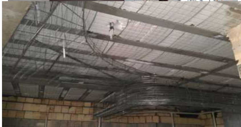
استفاده از رابیتس ، کلیک و شبکه فلزی برای زیر کار سقف اجرا شده با فوم
