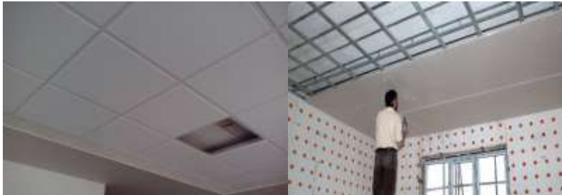
استفاده از رابیتس ، کلیک و شبکه فلزی برای زیر کار سقف اجرا شده با فوم
