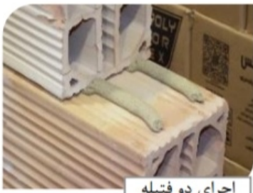
اجرای دو فتیله
